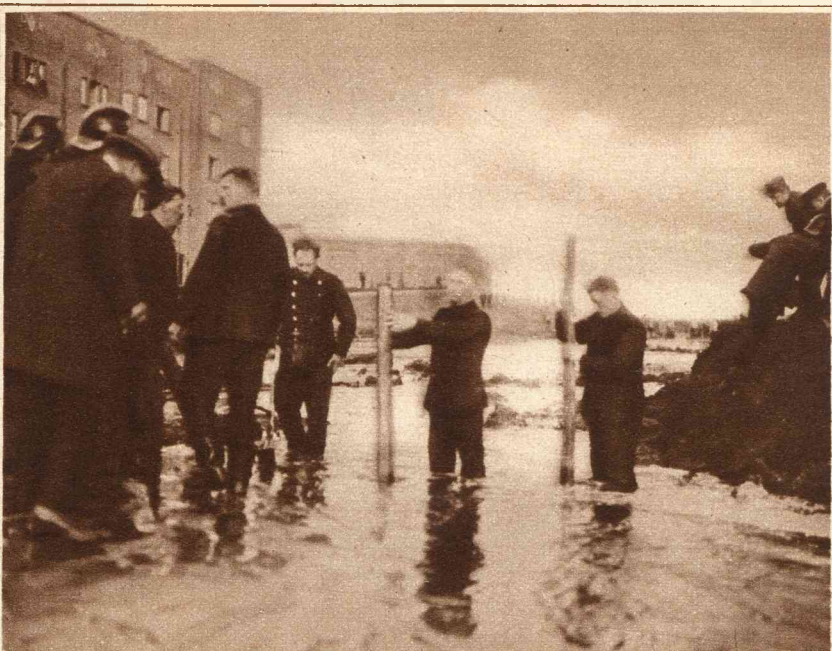
Een eigenaardige dijkdoorbraak! Het verbindingskanaal langs de Reinier Vinkeleskade, is van de Hobbemakade afgesloten door een zanddijk, die het water uit het verbindingskanaal, dat ongeveer een meter hoger staat, tegenhield. Eenige kinderen vermaakten zich met het graven van een geul in den zanddijk, die daardoor zeer verzwakt werd en op een gegeven oogenblik plotseling bezweek, tengevolge waarvan het water met groote kracht zich een weg baande naar de Hobbemakade. De onmiddellijk gealarmeerde brandweer — de brandweer is in Amsterdam overal goed voor, zelfs om het water te weren — maakte, met hehulp van de politie, van balken, steenen, zeildoek en wat maar te vangen en te grijpen was, een nieuwen dam. Hierboven, links; Een overzicht van het overstroomde terrein; rechts: Brandweerlieden, bezig met het aanleggen van een nieuwen dam.
