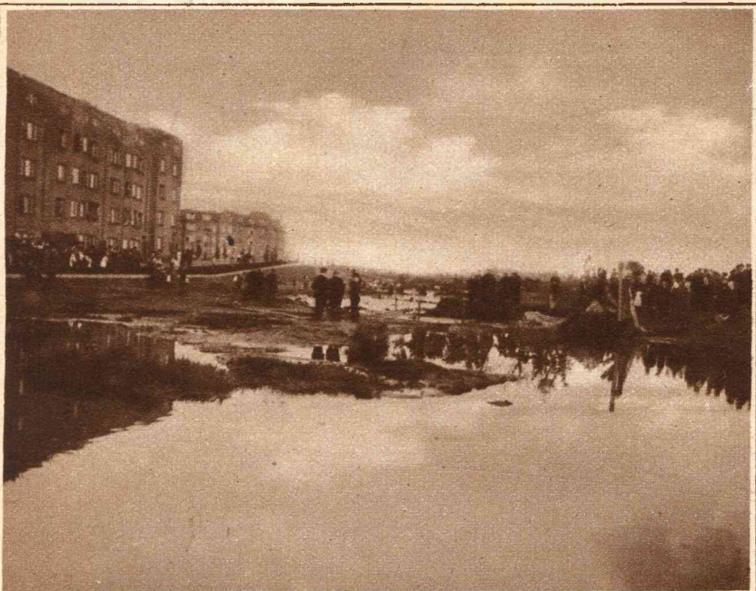
Een eigenaardige dijkdoorbraak! Het verbindingskanaal langs de Reinier Vinkeleskade, is van de Hobbemakade afgesloten door een zanddijk, die het water uit het verbindingskanaal, dat ongeveer een meter hoger staat, tegenhield. Eenige kinderen vermaakten zich met het graven van een geul in den zanddijk, die daardoor zeer verzwakt werd en op een gegeven oogenblik plotseling bezweek, tengevolge waarvan het water met groote kracht zich een weg baande naar de Hobbemakade. De onmiddellijk gealarmeerde brandweer — de brandweer is in Amsterdam overal goed voor, zelfs om het water te weren — maakte, met hehulp van de politie, van balken, steenen, zeildoek en wat maar te vangen en te grijpen was, een nieuwen dam. Hierboven, links; Een overzicht van het overstroomde terrein; rechts: Brandweerlieden, bezig met het aanleggen van een nieuwen dam.
