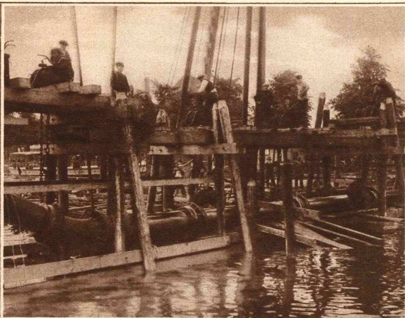
Aan den overkant van het Y, in het Noord-Hollandsche Kanaal, heeft men twee nieuwe zinkers, één voor het gas en een voor de waterleiding, laten zinken. Hierboven een tweetal foto's van dit moeilijke werk. Beide buizen die zijn saamgevoegd, worden te gelijk neergelaten. Links het hellende gedeelte, dat de verbinding moet vormen van de buis onder water, met het gedeelte in den weg; rechts: de buizen, zoover gezakt, dat ze juist het wateroppervlak raken.
