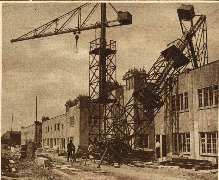
Vrijdag is een der kranen op het werk in het betondorp aan den Ringdijk door een windvlaag omgeworpen, juist toen een bak cement werd opgeheschen. De aan de in aanbouw zijnde woningen toegebrachte schade is slechts gering.
