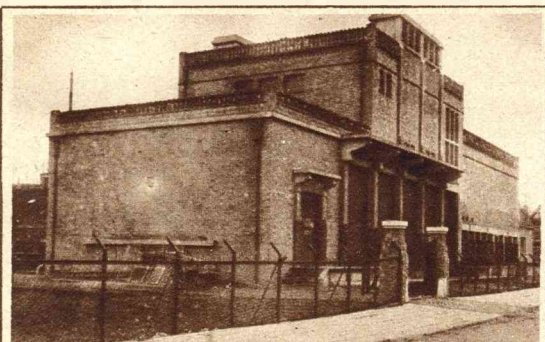
Het nieuwe moderne schakel- en transformatorgebouw te Wormerveer.
