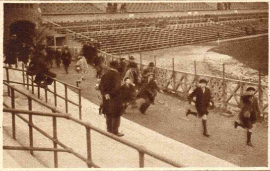
Het eerste staan-tribune-publiek komt het Stadion binnenstormen, om toch maar vooral een mooi plaatsje op den muur machtig te worden.
