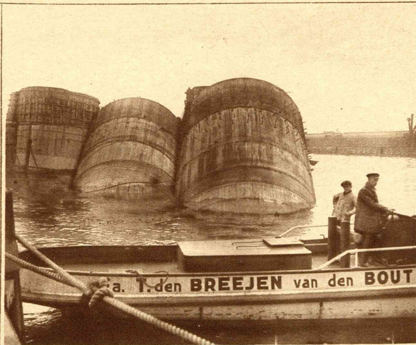
Links: Een overzicht van de Borneokade, waar de reusachtige meerstoelen voor de nieuwe sluizen te IJmuiden (zie de plaat op onze titel-bladzijde) worden vervaardigd. Deze foto geeft, door de vergelijking met de er voor liggende sleepboot, een duidelijk denkbeeld van de buitengewone afmetingen dezer gevaarten, waarvan men er rechts een van binnen ziet.
