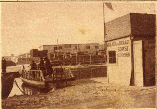
Het nieuwe pontje in den Noorderringdijk, waardoor een kortere verbinding is verkregen tusschen Watergraafsmeer en de Indische Buurt.
