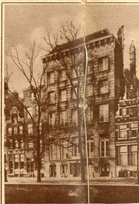
HET TWEEDE KANTOORGEBOUW DER N. H. M.
