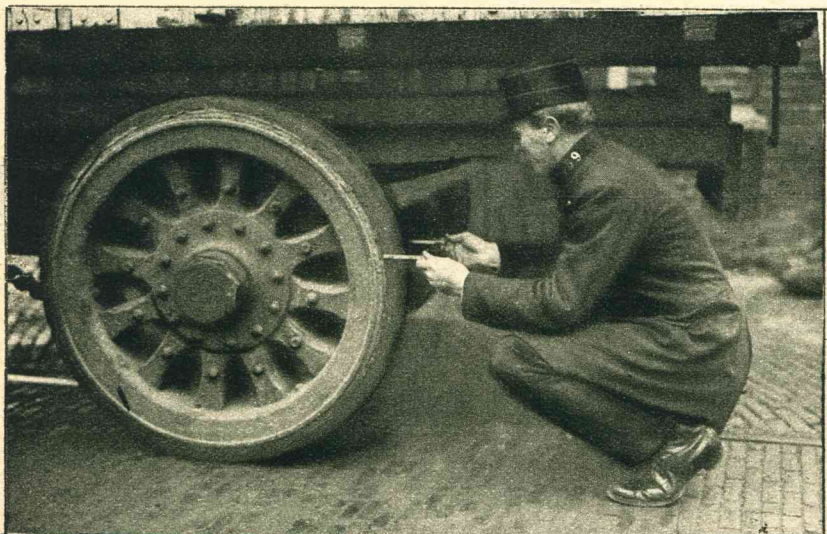
Het meten der dikte van den wielband.
