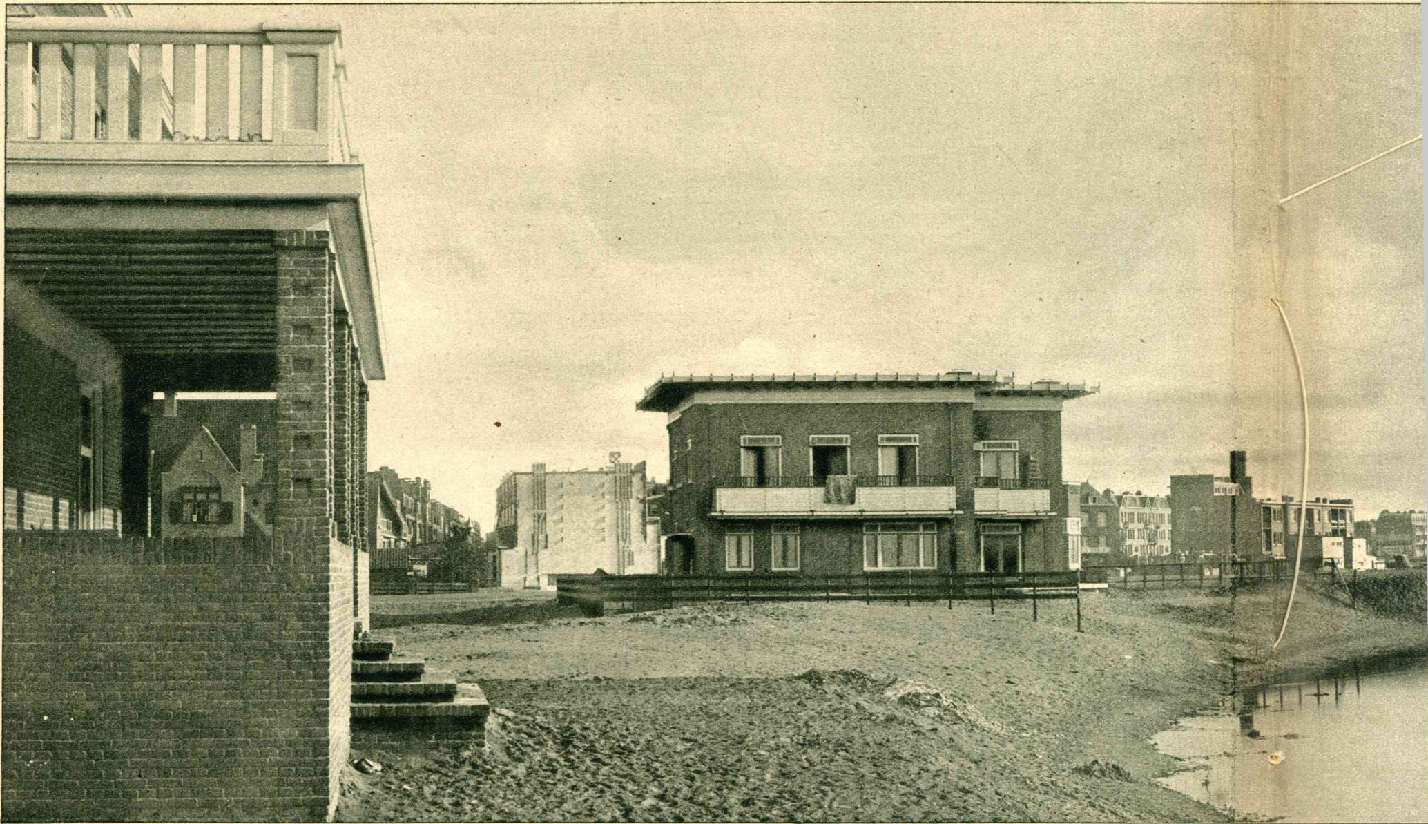
Gezicht, genomen van den hoek der Emmastraat langs de Pieter Lastmankade en de J. J. Viottastraat naar het Oosten der Stad. Rechts de nieuwe bouw
