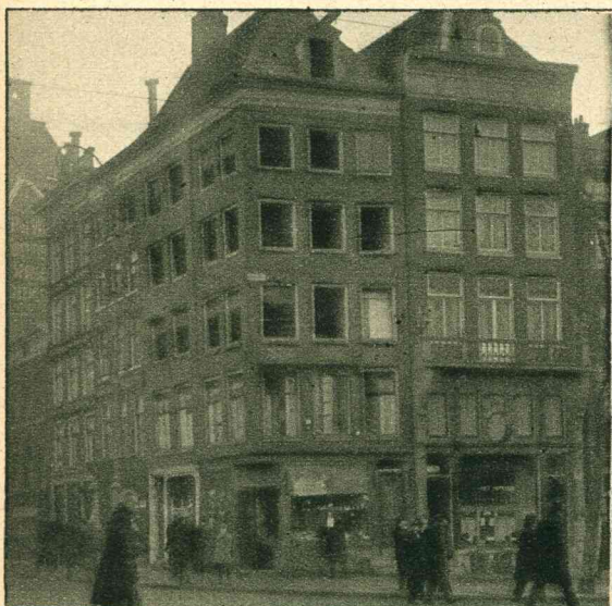
Het huis hoek N.Z. Voorburgwal en Paleisstraat, waarvan de eigenaar om de huurcommissie te beletten de bovenwoningen te verhuren, alle raamkozijnen heeft doen wegnemen.
