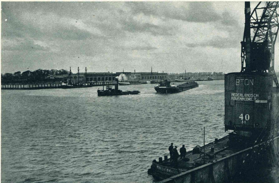
Overzicht van de nieuwe buitenhaven van Vlissingen, waarvan de totstandkoming op de eerste plaats is te danken aan het initiatief van burgemeester van Woelderer. De foto werd genomen van het bunkerstation.
