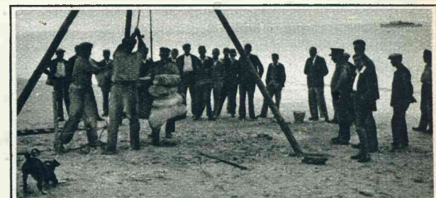
Door de vele successen aangemoedigd, steekt zeebad Vlissingen energiek de handen uit de mouwen en zoo zal men het volgend jaar 'n nieuwe attractie bezitten in een fraaie wandelpier. Met den bouw daarvan is dezer dagen reeds begonnen.
