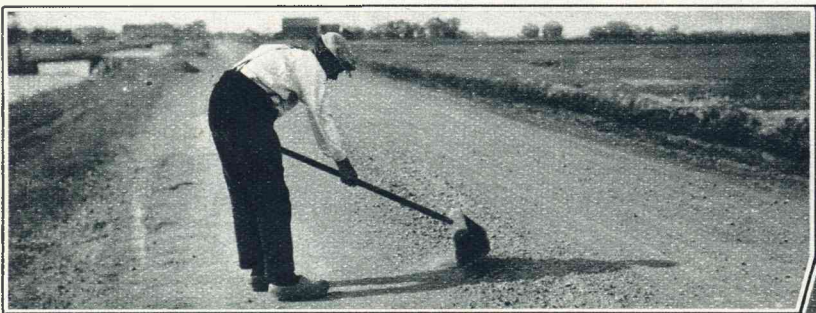
Het herstelwerk aan onze tertiaire wegen op Schouwen doet wel wat primitief aan. Het bijvegen van het grint op de wegen, waardoor deze voor het moderne verkeer levensgevaarlijk worden, vooral wegens vergroote kans van slippen.
