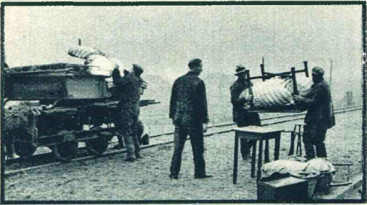
De inboedel van de keet gaat naar het nieuwe bouwwerk.
