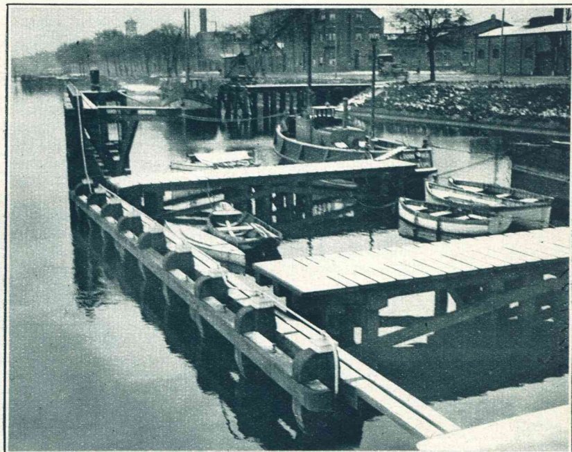
De aanlegsteiger en plankieren in het Kanaal door Walcheren zijn met een gladde ijzige laag sneeuw bedekt.
