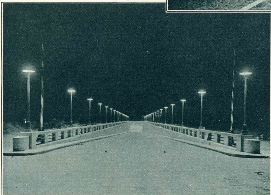
Na het bouwkundig gedeelte van dit grootsche werk gold de bijzondere belangstelling de uitnemende verlichting van den tunnel voor rijverkeer. De constructeurs van den tunnel lieten, na een grondige studie van dit probleem, de keuze vallen op een verlichting met Philips natrium-lampen. Het bereikte resultaat ziet men duidelijk op de beide hier afgebeelde foto's, van een der naar den tunnel voerende hellingen en van 't interieur. Hierboven: de ingang tot den tunnel, 170 meter lang verlicht met natrium-lampen. Hieronder: de tunnel voor rijverkeer, die een lengte heeft van 1769 meter en verlicht is met 532 Philips-natriumlampen van 100 W. — in den tunnelwand ingebouwd.
