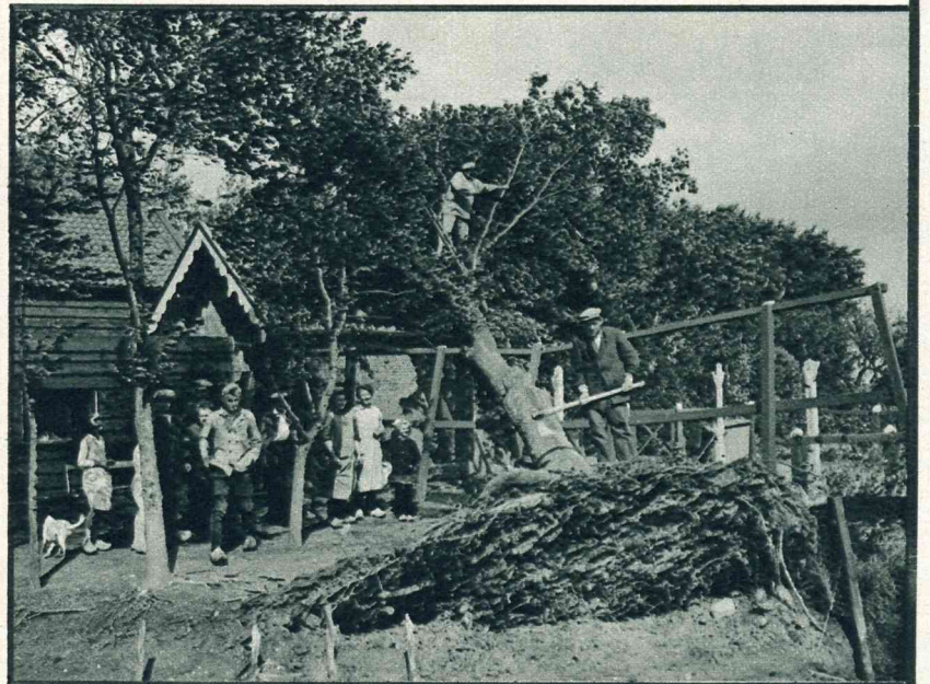
Een onwontende boom, die op het dak van een boerderij terecht kwam.
