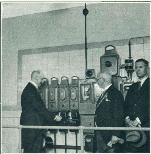
↖ De officiële ingebruikstelling van de waterleiding te Domburg op Maandag 28 August's. De Commissaris van de Koningin stelt de machines in werking
