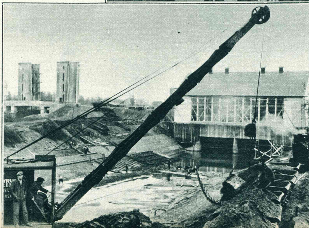
Het bemalingsgebouw (rechts) en de sluis met heftorens (links) van het Twente-Rijnkanaal bij Eefde (Gld.) zijn bijna gereed. Het laatste zand voor het kanaal is hier uitgegraven
