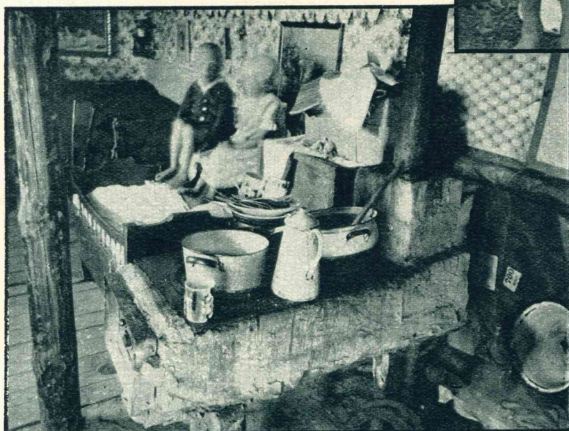
Een gedeelte van een ondergrondse woning in 't kamp buiten Berlijn; palen stutten het dak van losse planken, riet en zand.
