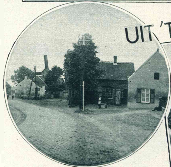
Het kostelijk lande- lijke Zuiddorpe.
