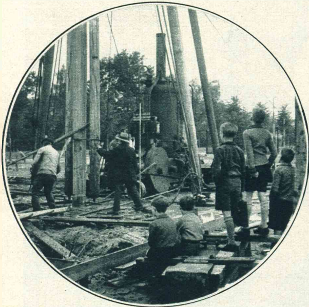
De heiwerken voor het te bouwen bedrijfsgebouw van de Broederband te Vlissingen, waarbij gebruik wordt gemaakt van betonnen heipalen, trekken als nieuwigheid in deze omgeving heel wat belangstelling.
