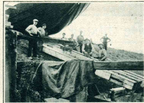
Het gereed maken van de stelling, om 't vaartuig erlangs te laten glijden in de Eendracht.
