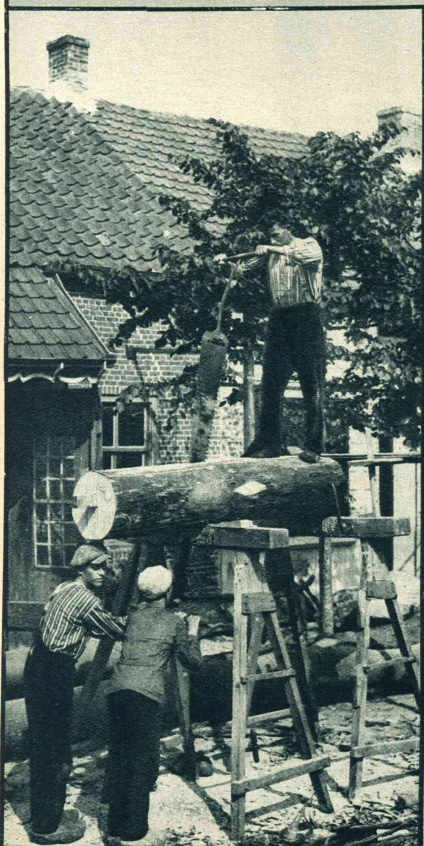
Hoe met de ouder- wetsche zaag wordt gezaagd, waarvoor drie man noodig zijn.
