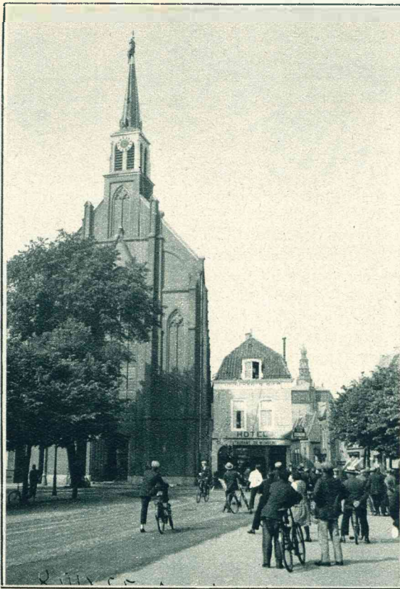
Acrobatisch werk. Op den top van den toren der St. Jacobuskerk te Vlissingen worden herstelwerken verricht, die heel wat belangstelling trokken.
