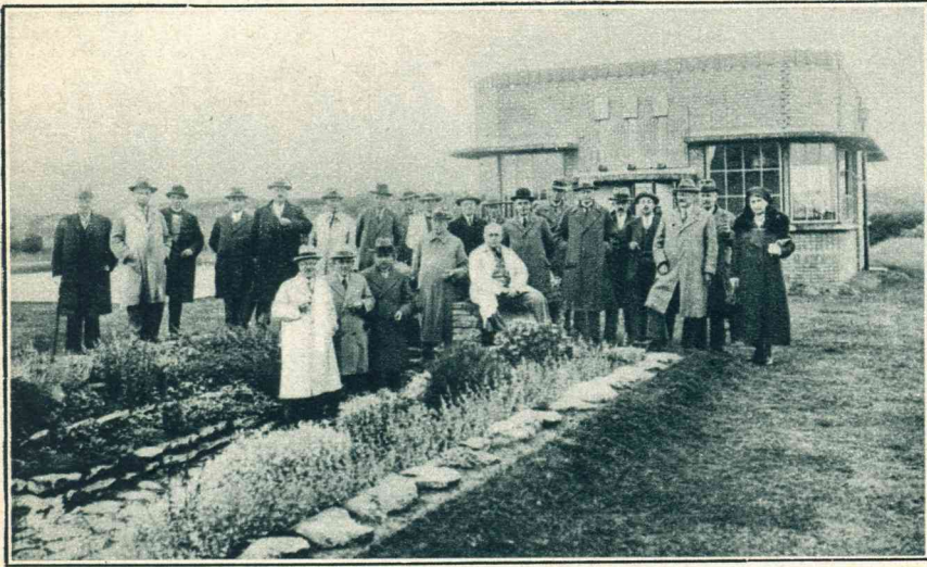
Het gemeentebestuur van Middelburg bracht een bezoek aan de voltooide prise d'eau der Middelburgsche waterleiding te Oranjezon.
