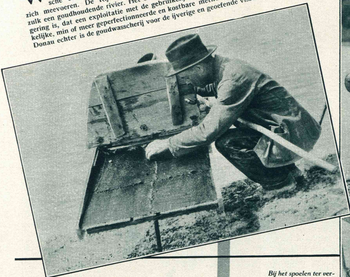
De werktuigen bij het goudwasschen zijn slechts zeer eenvoudig. Een waschapparaat, om aangespoeld goudstof te reinigen van zand, leem en andere onzuiverheden.
