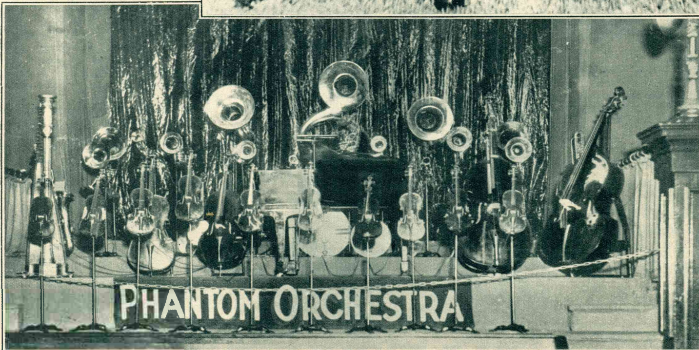
Den indruk van een geesten-orkest moet deze verzameling muziek-instrumenten wel op het publiek maken. Zekere Charles Smith heeft n.l. de uitvinding gedaan om de instrumenten door middel van 'n electrisch schakelbord te „bespelen“.
