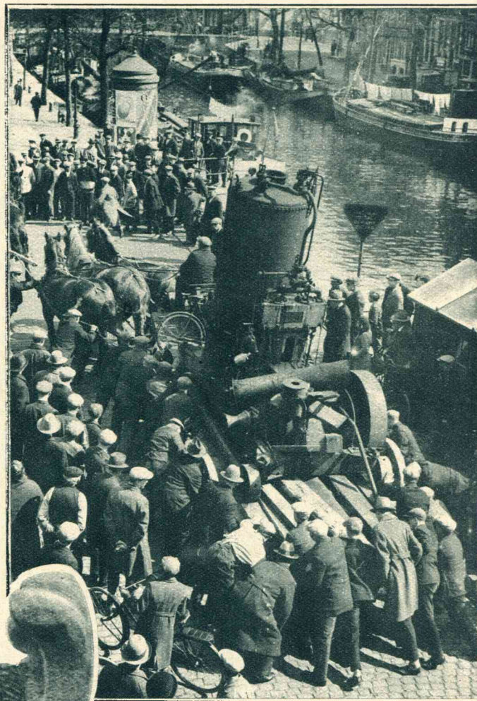
Een echt Amsterdamsch tafereeltje: De heimachine kan door geen vier paarden tegen de brug worden opgetrokken en nu is ieder bereid een handje te helpen.
