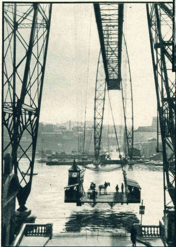
Het hoogst eigenaardige, zwevende veer te Marseille, dat met 40 kabels bevestigd is aan een soort brug hoog boven den haveningang, en menschen, dieren en voertuigen van den eenen naar den anderen havenwal transporteert.
