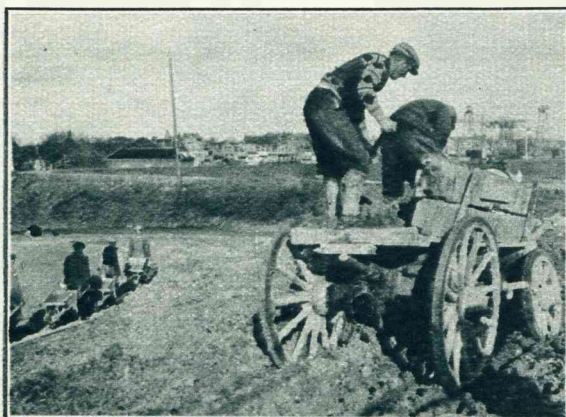
De aanvoer van grond ter verbreding van het Boulevardpad te Vlissingen, welk werk door Vlissingsche werklouzen wordt uitgeoerd.
