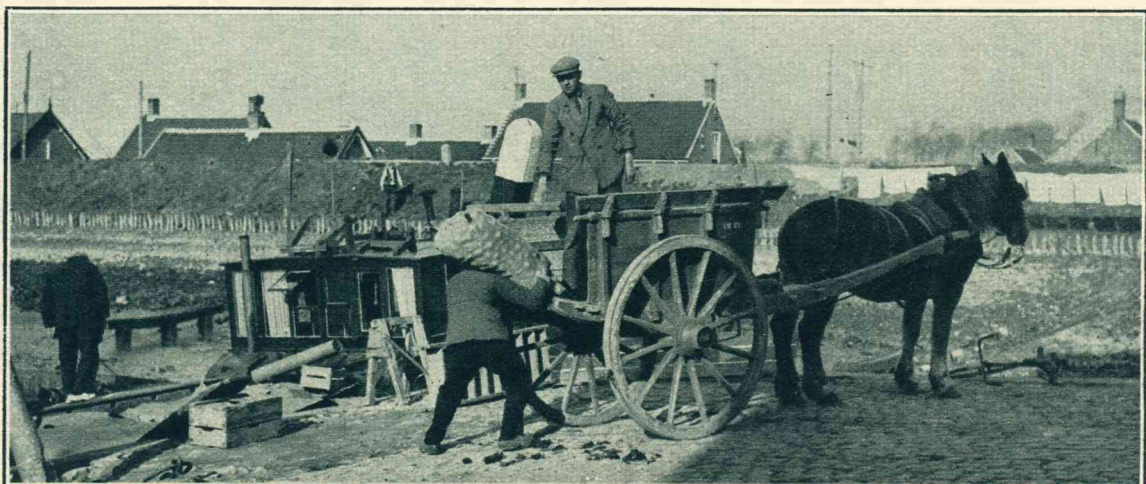
Nog een late zending uien te Stavenisse.
