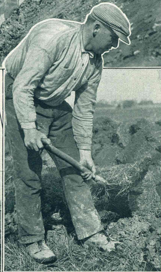
Crisisarbeid met schop
