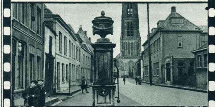
DE ST. MAARTENSTOREN EN DE POMP TE ZALTBOMMEL
