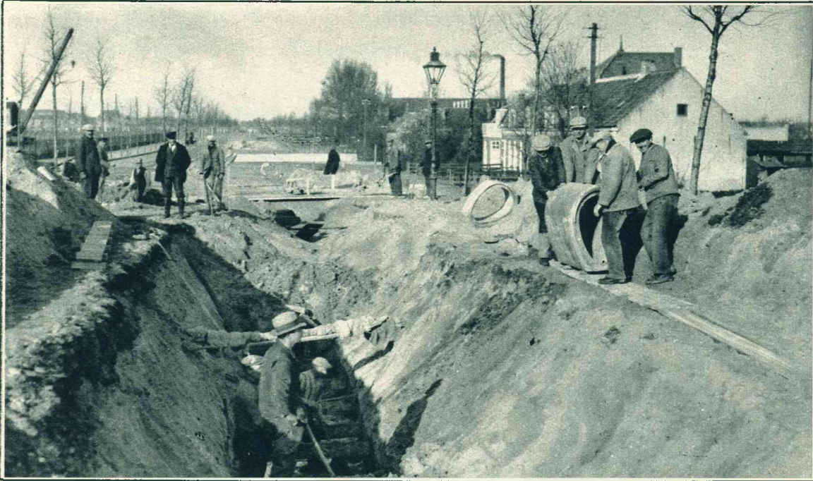
Langs den zeer verfraaiden Singel te Vlissingen worden thans de laatste voorbereidende werkzaamheden verricht om ook dit laatste gedeelte een opknapbeurt te geven en het voor het verkeer in te richten.
