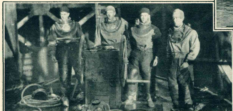
Het werk te IJansveert bracht de vier gebroeders-duikers Hardenberg, die hun vak in verschillende plaatsen des lands uitoefenen, bij uitzondering eens te zamen
