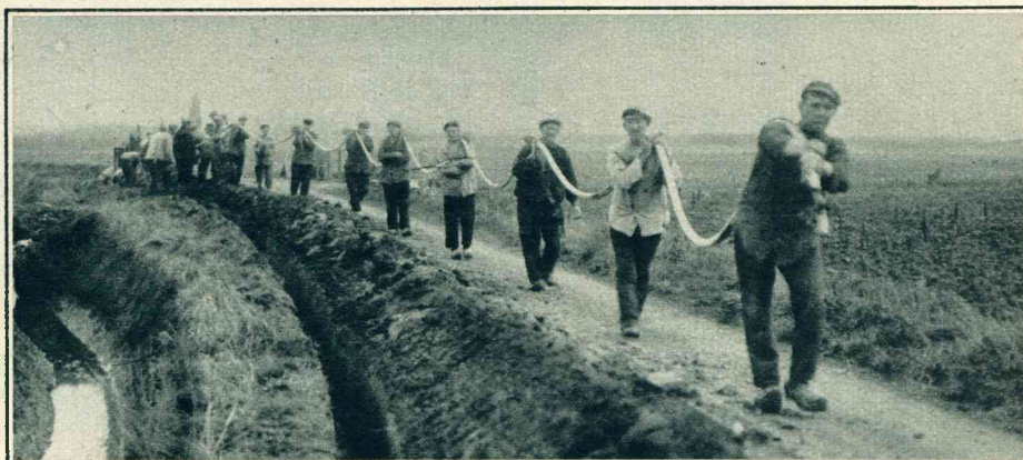
Het Oostelijk deel van Zuid-Beveland wordt nu door de P.Z.E.M. ook van electriciteit voorzien: te Schore wordt de hoofdleidingskabel uitgerold.
