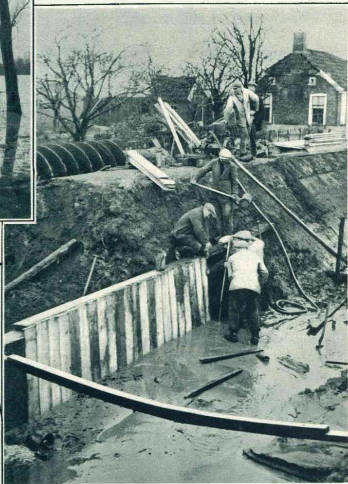
Onmiddelijk werd met de herstellingswerkzaamheden een aanvang gemaakt.
