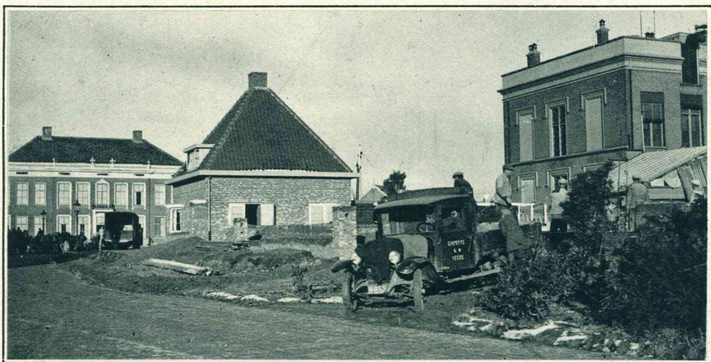
De wegverbetering en de verbouwing van de voormalige strafgevangenis te Goes nadert de voltooiing. Foto van de huidige situatie ter plaatse.
