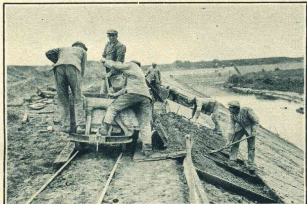
Kijkje op de werkzaamheden van de nieuwe vluchthaven te Zijpe, waarvan de dijken binnenkort gereed komen.
