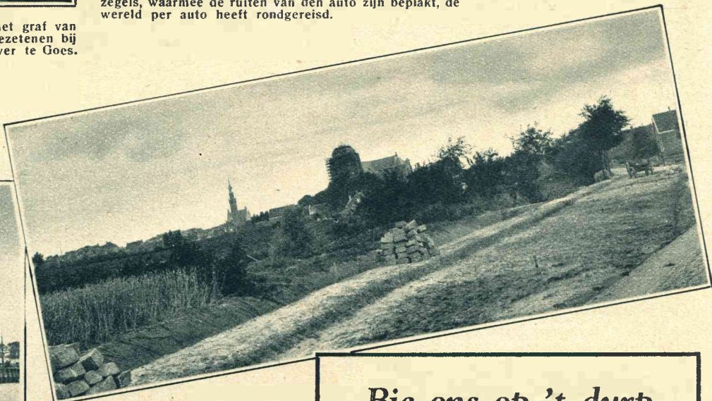
Restaureerend Veere. — Aan de restauratie van den weg naar Veere wordt thans de laatste hand gelegd. Bij dit fraaie gezicht op het oude stadje van af de wegwerken valt de steiger op om den ouden kerktoeren ten behoeve van diens restauratie.
