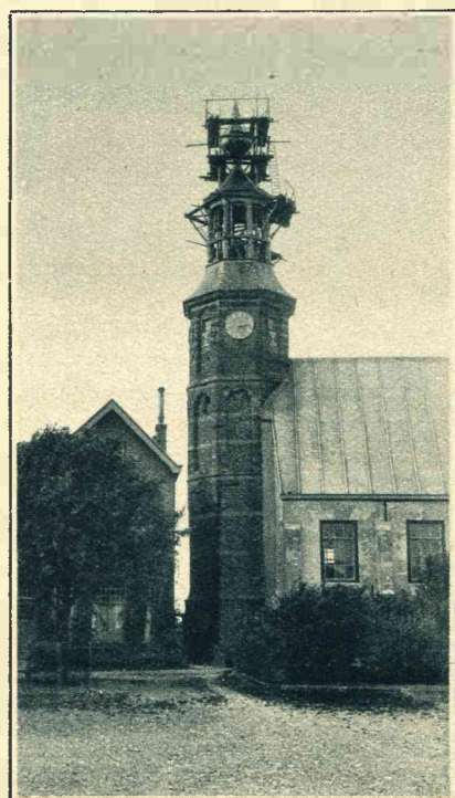
De toren van het kerkje te Kattendijke wordt vernieuwd. Foto van het werk.
