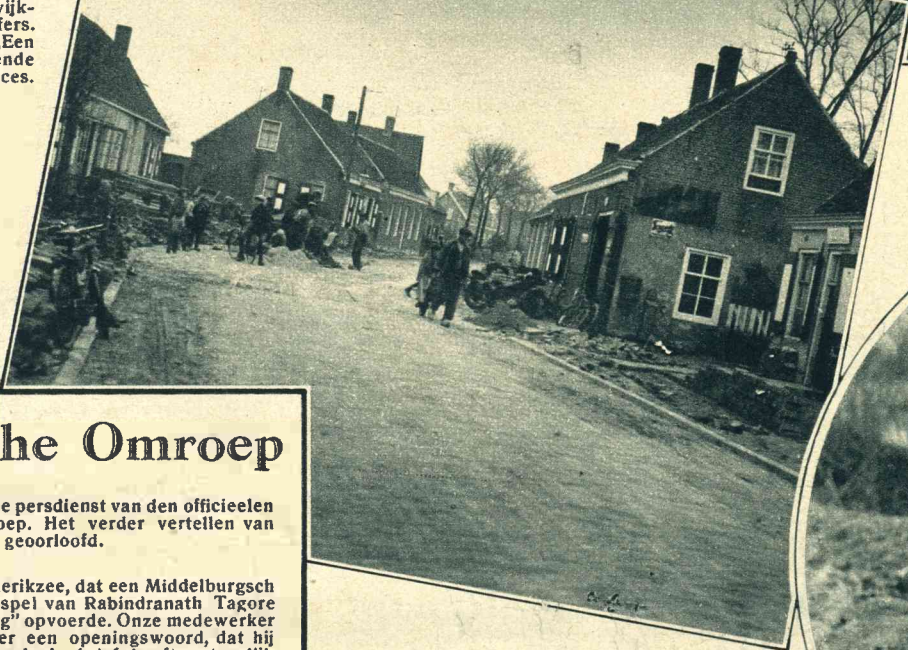
Brigdamme en St. Laurens krijgen nieuwe bestrating, wat 'n verbetering belooft te worden. Foto van de werkzaamheden te Brigdamme.
