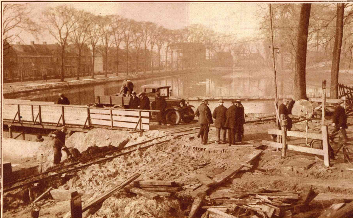
De werkzaamheden aan de Langevielebrug te Middelburg beginnen vorderingen te vertoonen. Thans worden de betonnen sluiswerken aangevuld met grond, waarvan hier 'n overzichtje.
