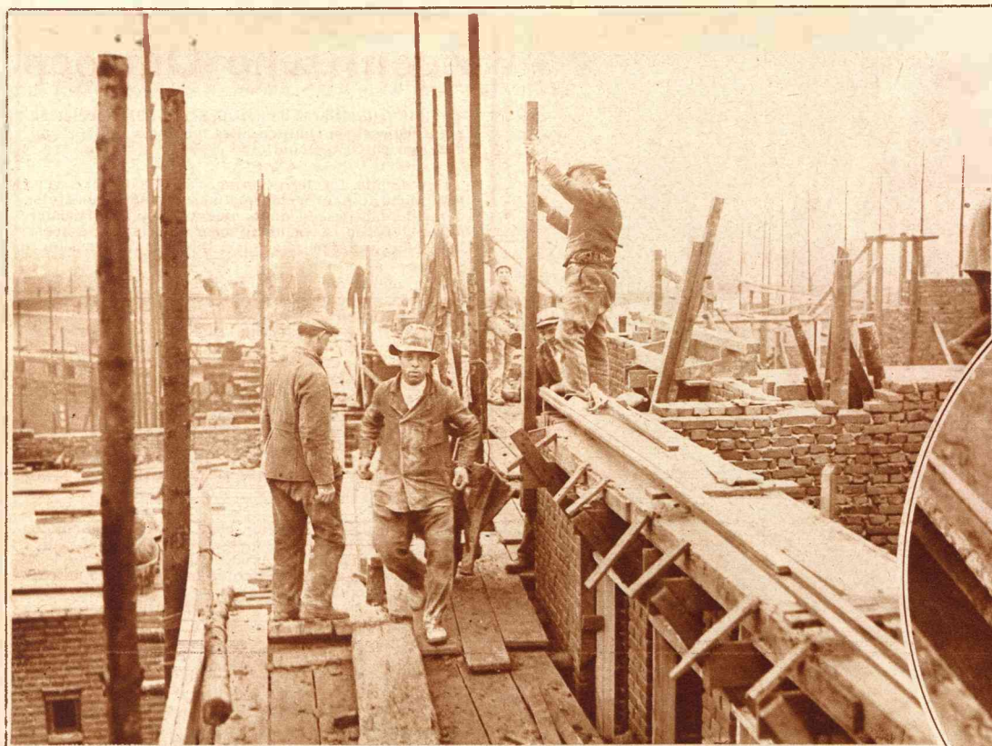
De bouw van het Christelijk ziekenhuis „Bethesda” te Vlissingen is reeds een flink stuk boven den grond gekomen. — Foto op de bovenste stelling.
