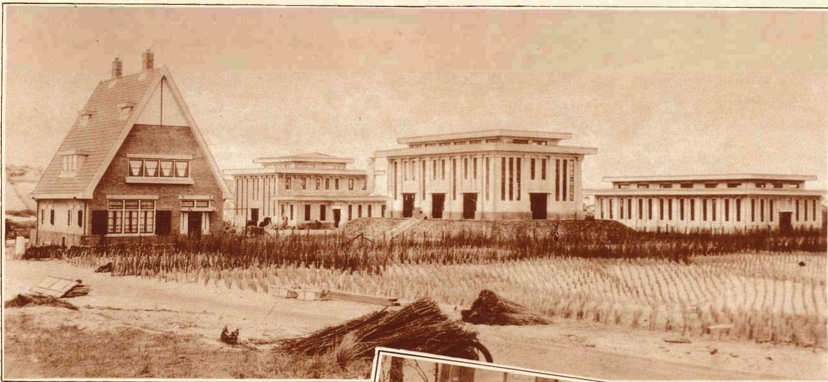
Binnen enkele dagen wordt de Schouwen-Duivelandse Waterleiding officieel geopend. Het Pompstation de Blinkert in de duinen onder Burgh geeft een bijzonder mooien indruk.
