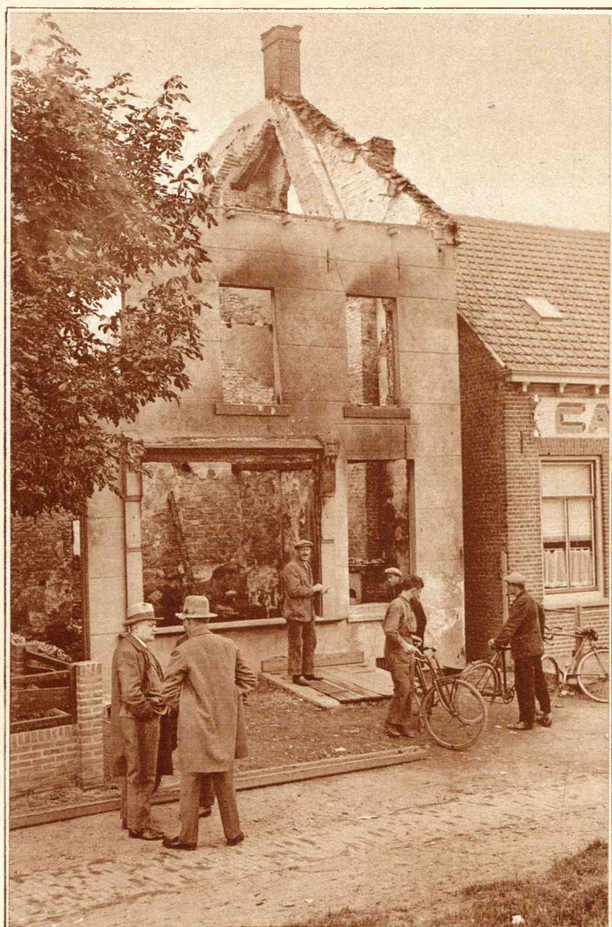
Te Breskens brandde verleden week de winkelwoning af van den heer F. van Meenen. Door krachtig optreden van de brandweer wist men de belendende perceelen te bewaren. Foto van 't geraamte der uitgebrande woning
