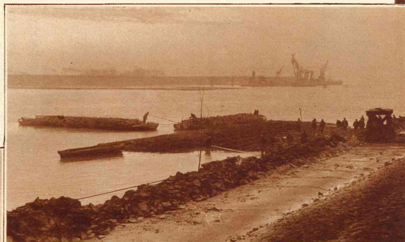
TE VLISSINGEN is men druk bezig met den aanleg van een nieuwe haven, welke, na voltooiing, ongetwijfeld een aanmerkelijke vooruitgang zal zijn voor den Vlissingschen handel en de scheepvaart. Kijkje op de haven, waar de oevers versterkt worden met stukken zink
