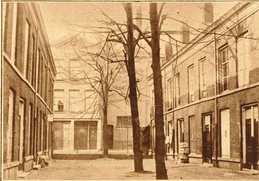
Binnenkort zal een aanvang worden gemaakt met het sloopen der huizen in de Lindelaan te Rotterdam. Foto van de verdwijnende panden.
