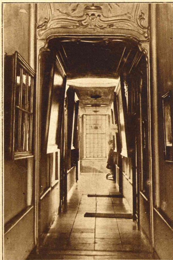
HET STADHUIS TE GOES. — De gang op de eerste verdieping, waar verschillende vertrekken van gemeentewerken op uitkomen.
