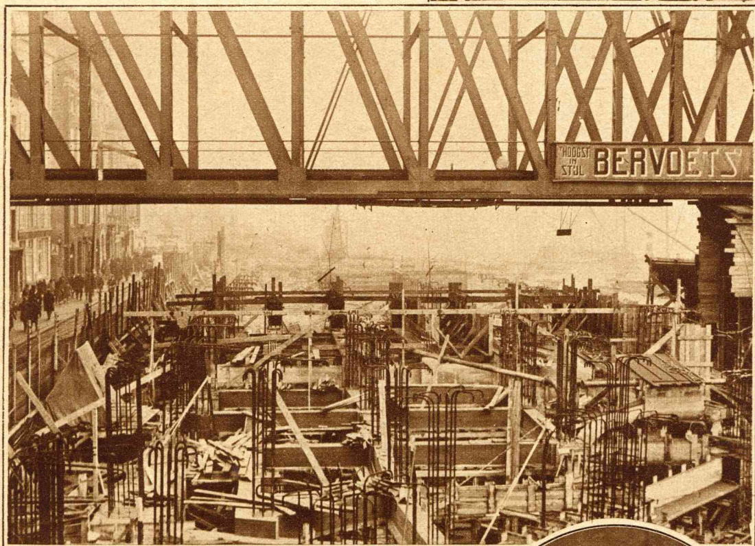
Een kijkje bij de werkzaamheden voor den oprit aan het Bolwerk, dat verbonden wordt met den oprit aan de Boompjes. Zij zullen samen één geheel vormen, waardoor de Willemsbrug aan beide kanten te bereiken zal zijn.
