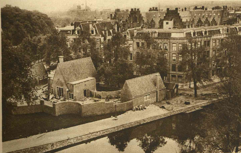
Het Pompstation F. te Amsterdam
