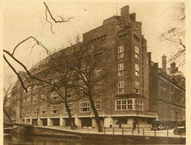
De verbouwing van het Stadhuis te Amsterdam. Hoever men thans reeds met de verbouwing gevorderd is.
