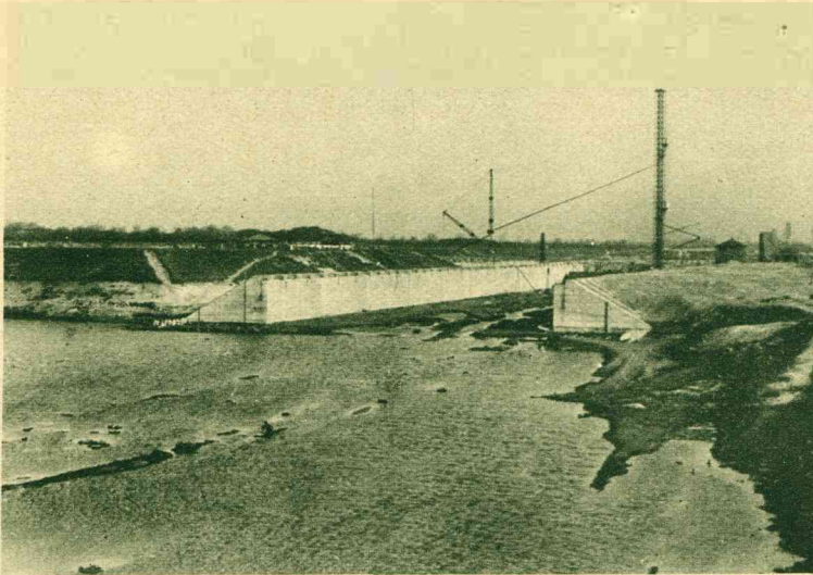
De sluizenbouw te IJmuiden
