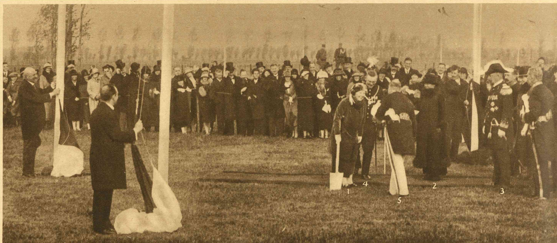
TE LIMMEL H.K.H. Prinses Juliana op het punt de eerste aarde te verwijderen voor het ontworpen Juliana-kanaal. Deze nieuwe waterweg zal de verbinding vormen tusschen het kanaal Luik-Maastricht en de ten Noorden van Maastricht gekanaliseerde Maas. Het eigenlijke Juliana-kanaal zal te Limmel beginnen. (1) Prinses Juliana; (2) H.M. de Koningin; (3) Prins Hendrik; (4) Mr. L. B. J. van Oppen, burgemeester van Maastricht; (5) Z. Exc. Bongaerts, Minister van Waterstaat.
