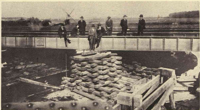
De vernieuwing van de Spoorwegbrug over de Haarlemmer Trekvaart
