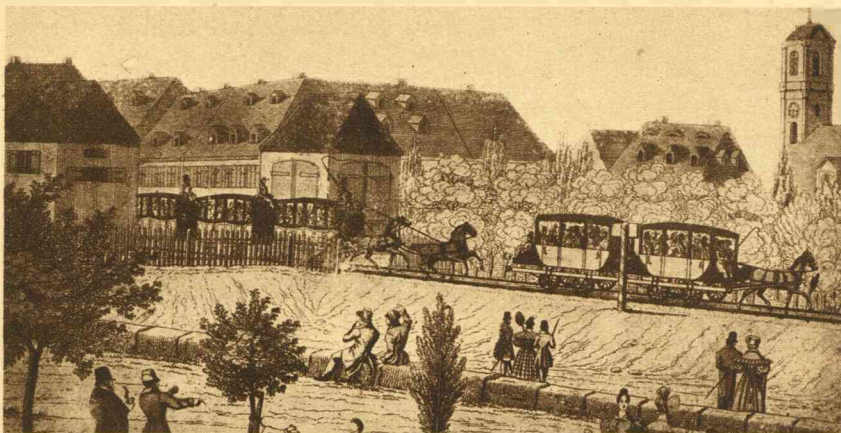
Toen in Engeland reeds lang stoomlocomotieven gebruikt werden, trokken in andere landen nog steeds paarden de „treinen” voort. — De z. g. Ludwigseisenbahn in Duitschland.
