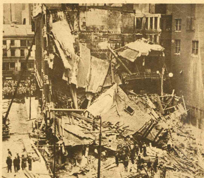
Het gebouw van de Pickwick-Club te Boston ingestort
